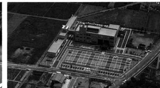
メイン事業の役場庁舎・保健センター
