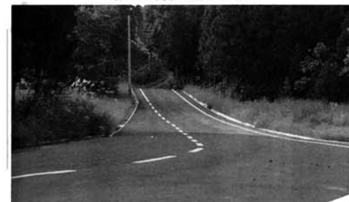
(蓮脇線)改良工事
