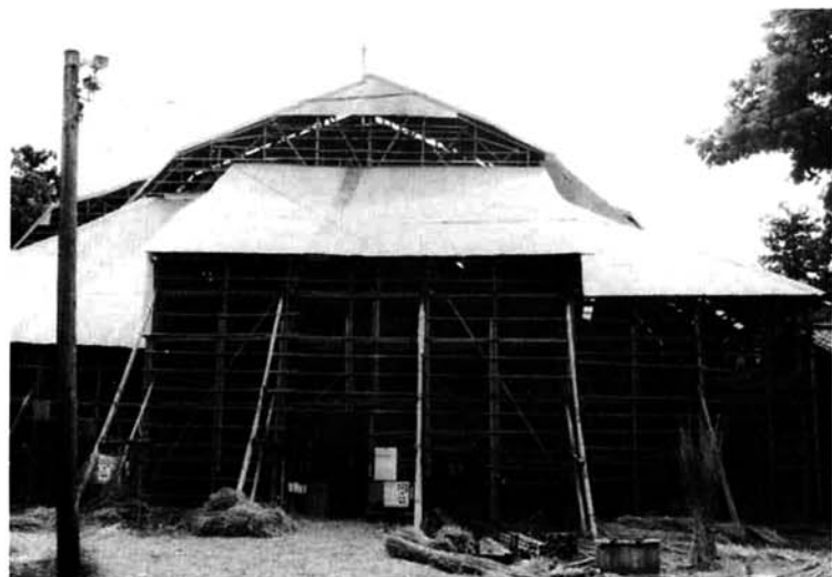
▲ 素屋根全景 主屋がすっぽりはいつている
