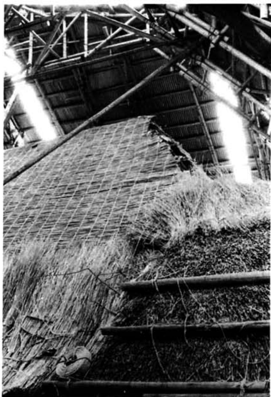
素屋根の内部 ▼ 茅の束を一段づつ葺き上げる
