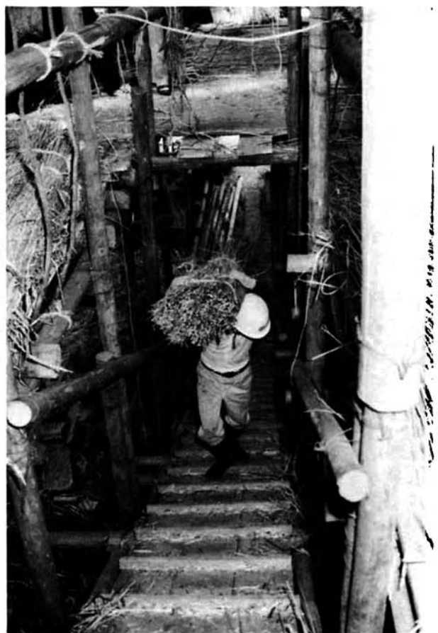
▶ 十メートル余の上り様橋をかつぎ上げる
