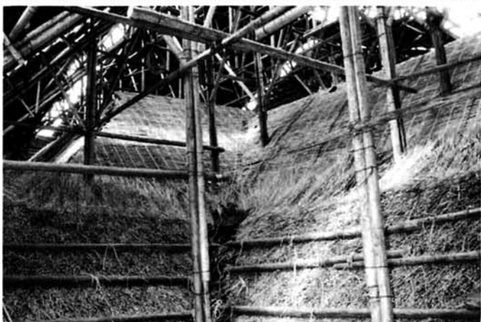
素屋根の内部 ▼ 茅の束を一段づつ葺き上げる
