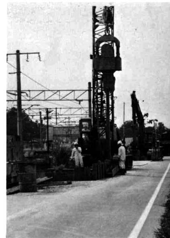
▼下水道工事急ピッチで進む(岩塚駅付近)
