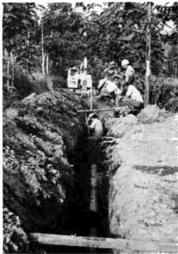
西谷地内中匠管工事
