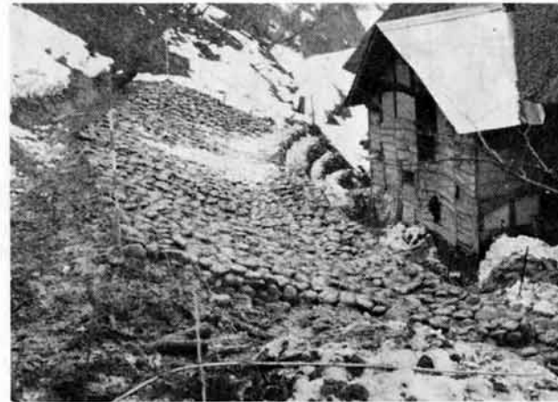
完成した地すべり防止工事
