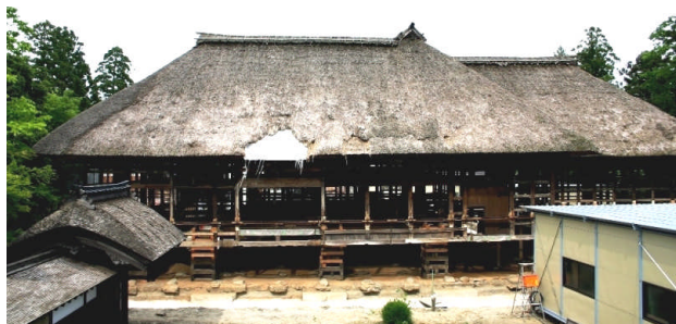
持ち上げられた長谷川邸の主屋
