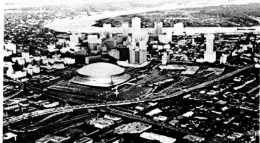
▲ ルイジアナ・スーパードーム（中央の丸い建物）ニューオリンズ市街地の中央部にある巨大な室内競技場、8万人収容の世界最大のもの
