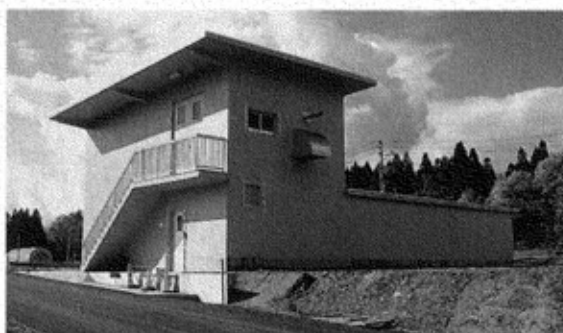
▲新たに完成した中央簡易水道第4配水池 (相川)
