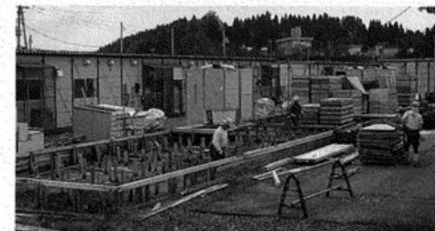
仮設住宅の解体作業 (泉水小学校仮設住宅)
