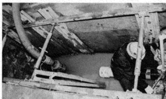
▲ガス管の復旧工事
