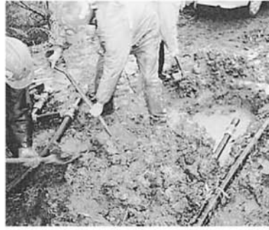
水道管修繕工事
