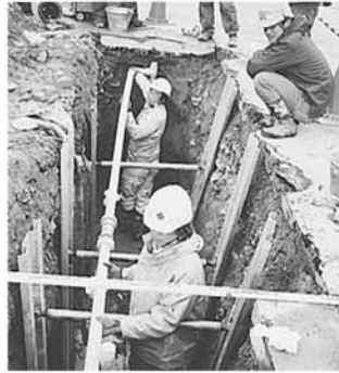
◀ガスの復旧工事
