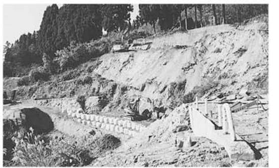
▲県道小千谷川口大和線の復旧工事
