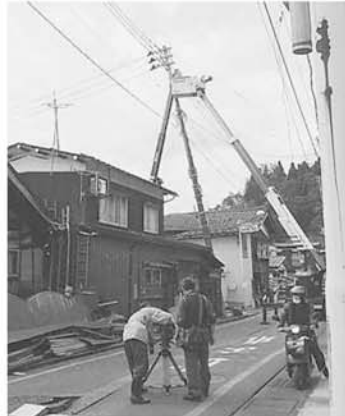
◀電気の復旧作業 全町で概ね使用可能
