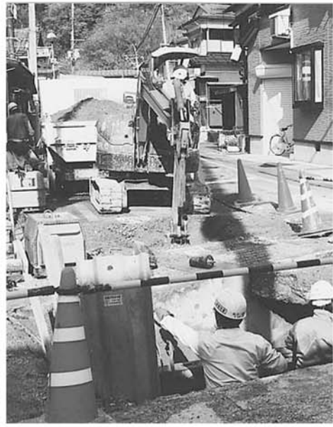
▲復旧作業は急ピッチで進む
