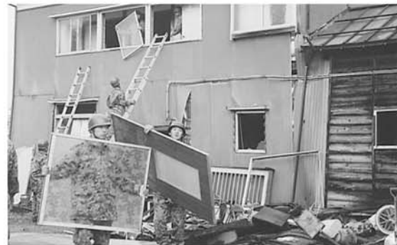
自衛隊の家屋解体作業
