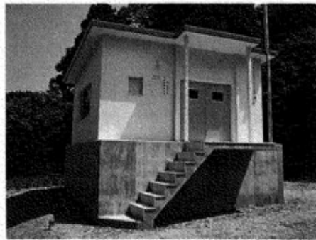
▲中央簡易水道 荒谷地区配水池
