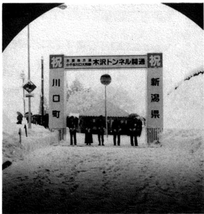
▲木沢トンネル「開通式」 12月13日 木沢地区出入口で
