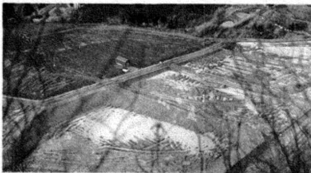
▲日影地区ほ場整備 (木沢市内)
