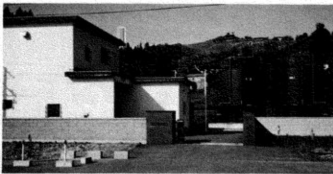
▲ 中央簡易水道浄水場
