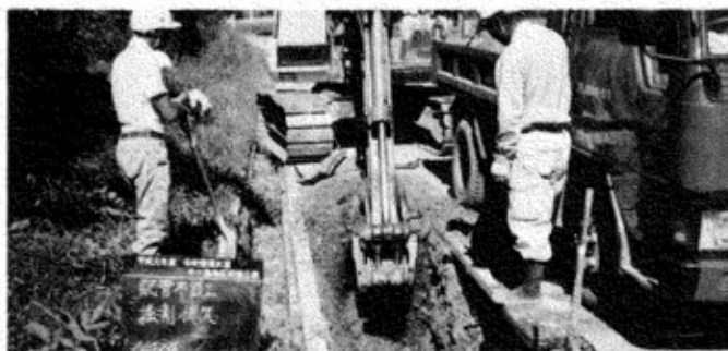
10月給水を目指して順調に工事が進む 写真…配水管布設による掘削 牛ヶ島地内で
