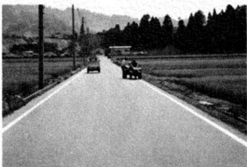
▲桑巻農道 立派な舗装道路に
