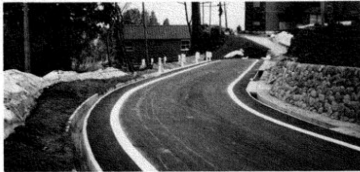
▲木沢農道改良舗装 昭和62年度完成
