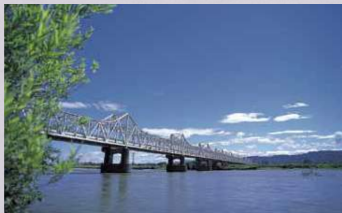
信濃川右岸からみた現在の長生橋
